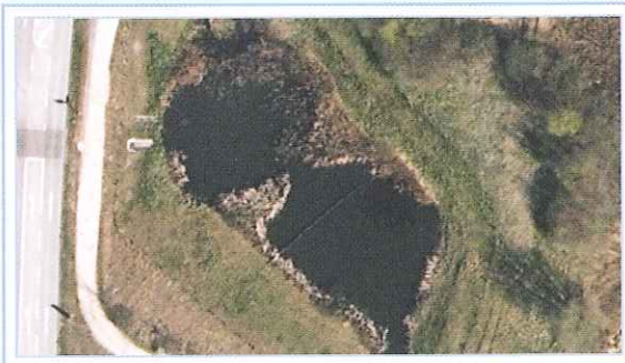
Abb. 1, oben: Fotodokumentation eines Einlaufbauwerkes vor Ort Abb. 2, unten: Luftbild zweier Regenrückhaltebecken
